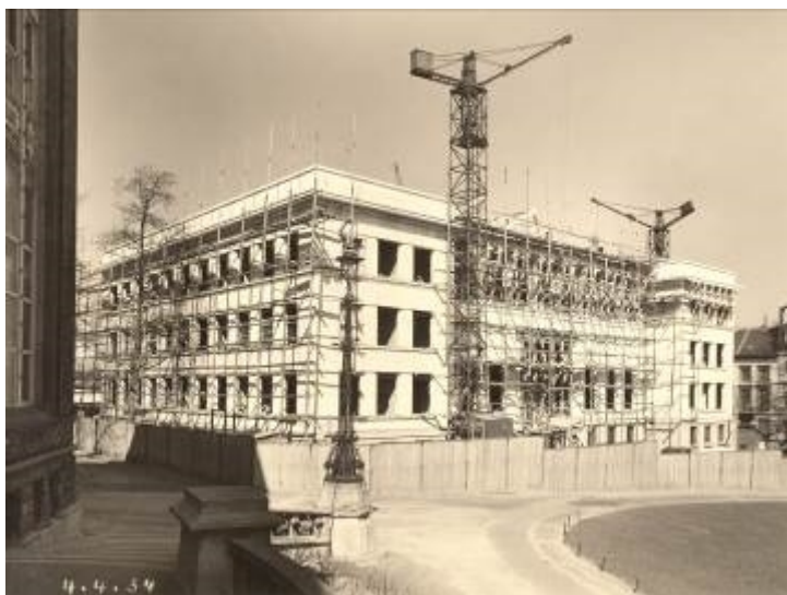
Slika 1 – Gradnja Eastmanovega inštituta, 1934
