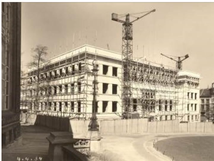
1. ábra – Az Eastman Intézet építése, 1934.
